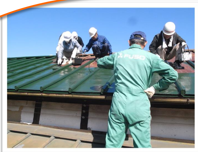
旧川田駅舎の屋根塗装
